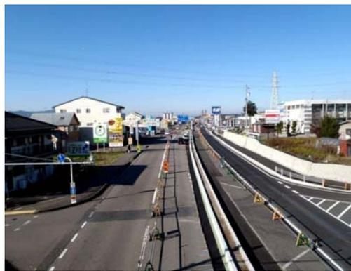
国道41号バイパスと交差し大変多くの車が行き交います。太田バイパスは緊急輸送道路に指定されており、大規模災害時の広域的な連絡機能を担っています。大縄手交差点から西町8交差点付近は年度内の4車線化を目指して現在工事中です。この工事では車線の切り替えから完成までが1年となる様、次のような工夫がされました。
